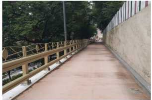
토성돌레길 황토콘크리트 포장
