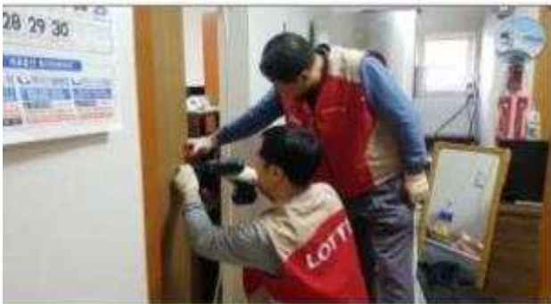
롯데 C/S 건설 봉사단 집수리 봉사
